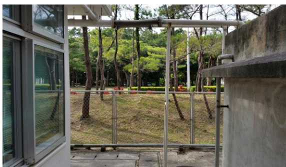
写真8 非常用通路口の設置予定地 (左:小学部棟、右:高等部棟)
