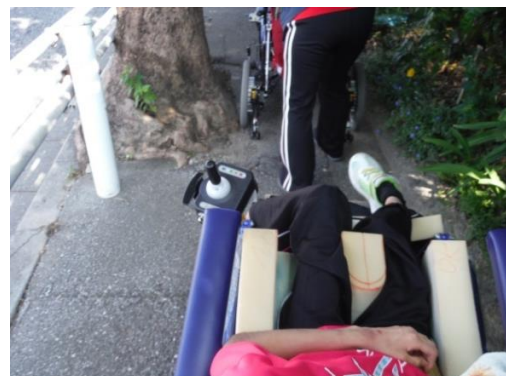
写真2 改善が必要な比屋根バス停近くの歩道
